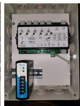
Skrzynia SKD i rozdzielacze pow. V kondygnacji
