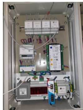
Skrzynia SKD i rozdzielacze pow. V kondygnacji
