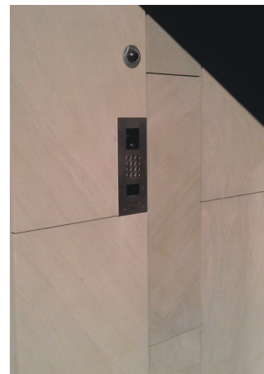
Montaż w budynku kasety z kamerą zewnętrzną
